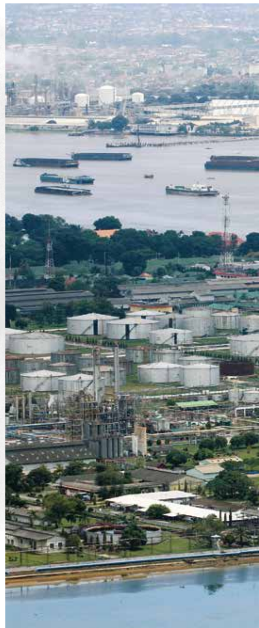
Komplek kilang minyak milik Pertamina (Persero) Refinery Unit (RU) III Plaju – Sungai Gerong, Palembang, Sumsel, Sabtu (2/5).
