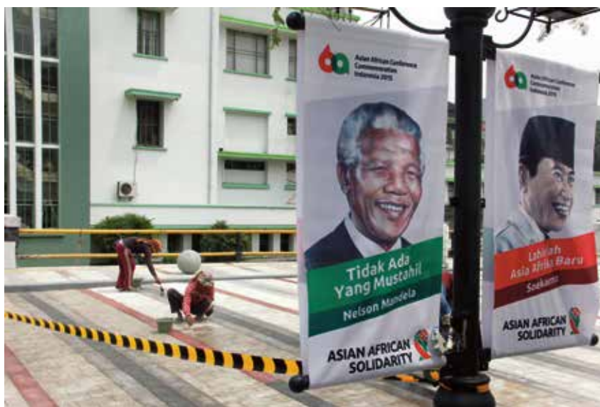
Pekerja menyelesaikan renovasi perbaikan trotoar jalan Gedung Merdeka di jalan Asia - Afrika, Bandung, Jumat (3/4).
